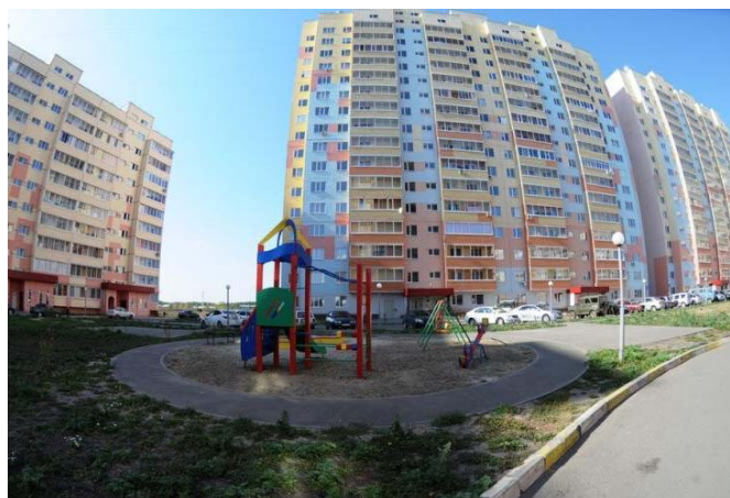
Жилой район «ЮГО-ЗАПАДНЫЙ»
